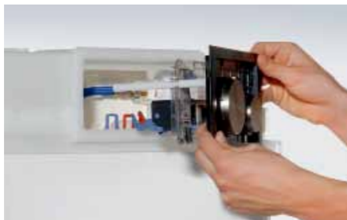
Demontering av betjeningsenheten
