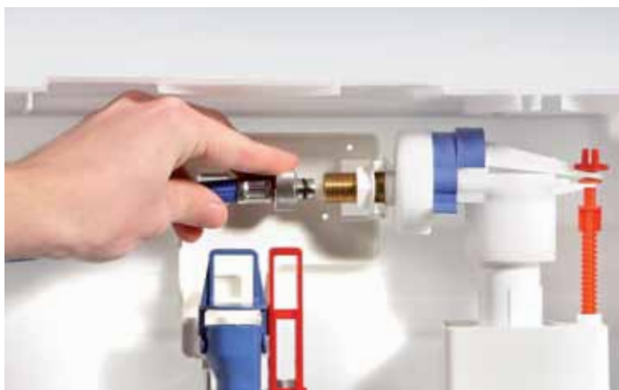
Anslutning av den armerte slangen til flottørventilen
